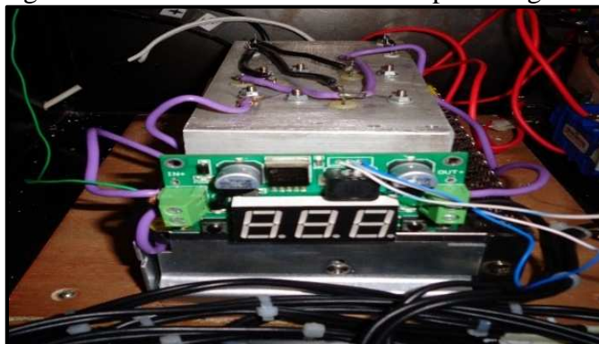
Figura 68. Instalación de la fuente de poder regulable
