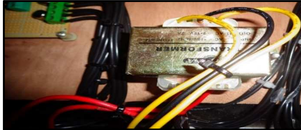
Figura 69. Instalación del transformador 110V/24V/2A
