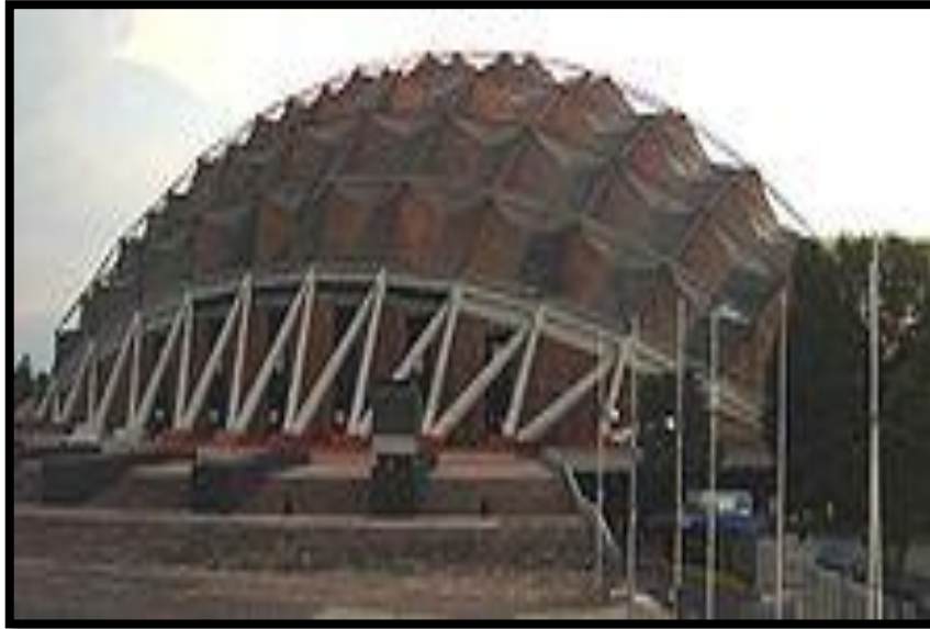
Figura 3. Cubierta del palacio de los deportes de México D. F. construida en 1968 con cobre expuesto a la intemperie.
