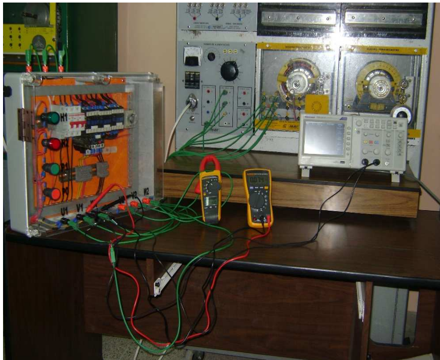
Figura 19. Equipos, aparatos de maniobra y accesorios básicos que conforman la estación de medición
