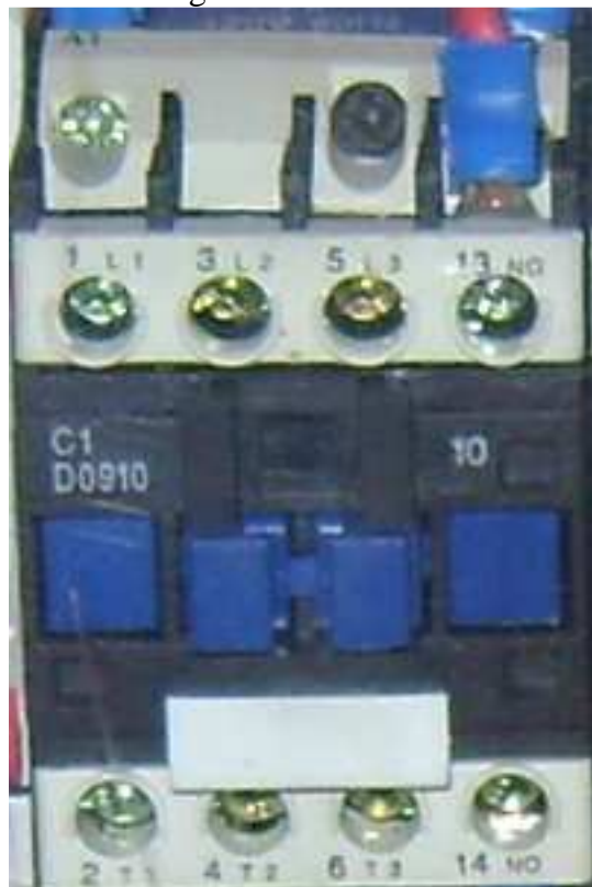
Figura 28. Contactor
