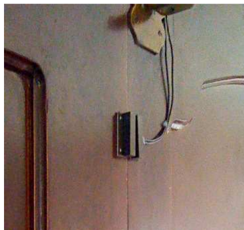
Figura IV.33. Contacto magnético.
