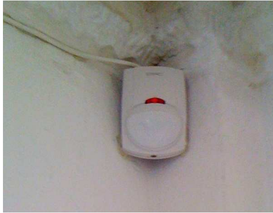
Figura IV.34. Sensor infrarrojo de movimiento.
