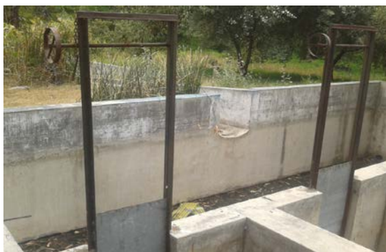
Gráfico 4. Desarenadores paralelos rectangulares.
