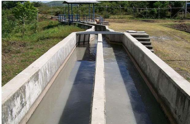
Figura 4. Pre-tratamiento con desarenador rectangular flujo horizontal
