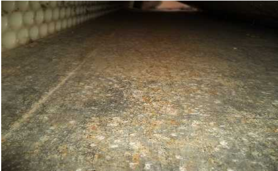
Fotografía 4. Tubería sin presencia de biofilm-Resultados de prueba ensayo Fuente Oxidante y Fuente Preservante INTEROX
