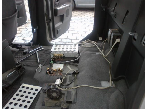
Fig.V. 1 Instalación del RTU 121
