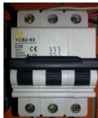
Figura III. 32 BREAKER PARA EL MOTOR
