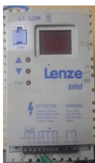
Figura III. 21 CONVERTIDOR DE FRECUENCIA DEL SISTEMA ANTERIOR
