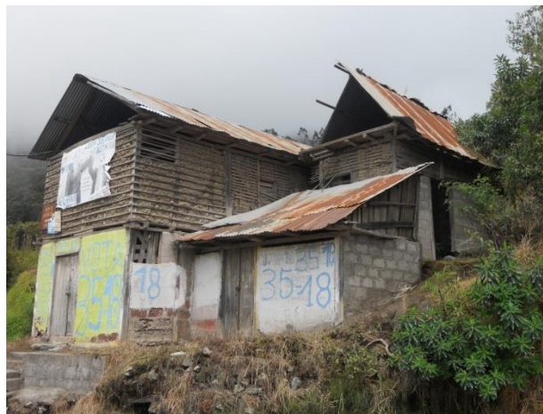
Foto N° 26. Construcciones tradicionales Fuente: Auquilla Cargua Ana
