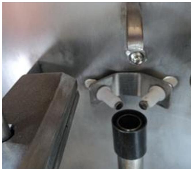
Figura 62. Instalación de encendedores
