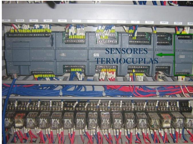
**Figura V. 85:** Conexión de las electroválvulas
