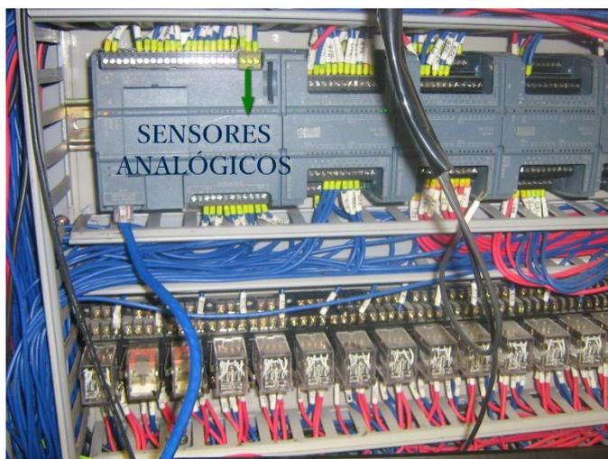
**Figura V. 84:** Conexión de las electroválvulas
