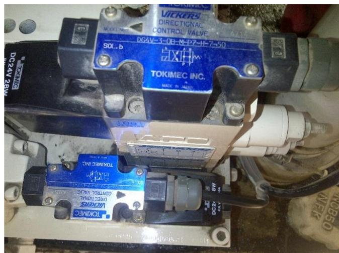
**Figura V. 76:** Identificación de las válvulas de control direccional
