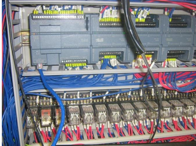
**Figura V. 87:** Montaje, alimentación y conexión al PLC
