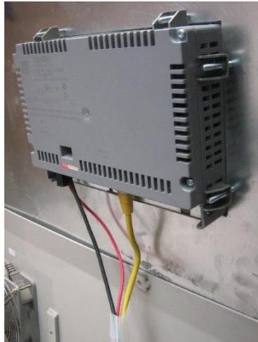
Paso 7: conexión PLC – HMI
