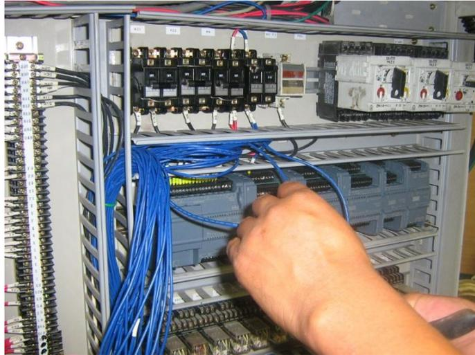
**Figura V. 81:** Colocación y ajuste de las E/S digitales
