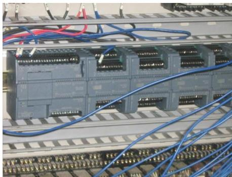
Paso 5: Conectar las E/S del PLC y módulos
