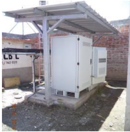
ESTRUCTURA METALICA Y BASE DE CEMENTO PARA LA COLOCACIÓN DE EQUIPOS
