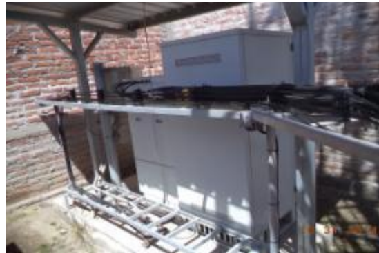
ESTRUCTURA METALICA Y BASE DE CEMENTO PARA LA COLOCACIÓN DE EQUIPOS
