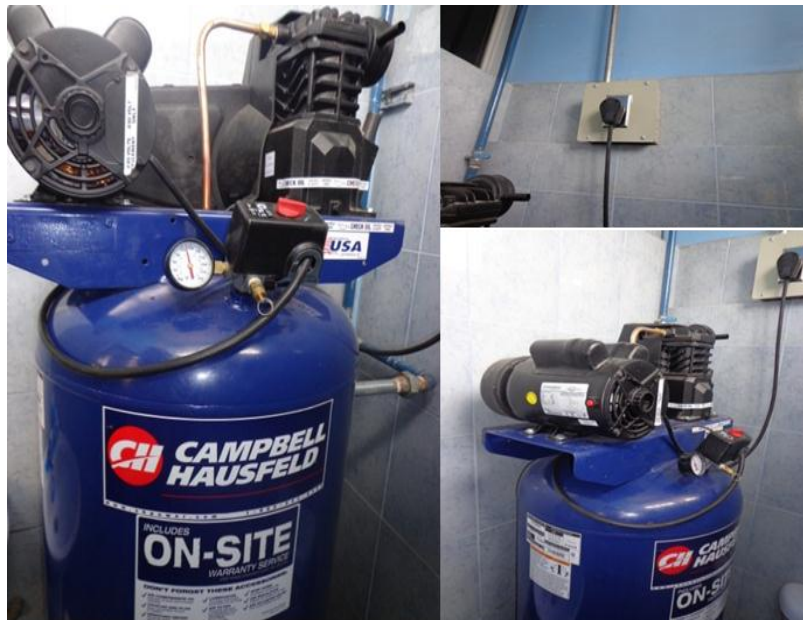
Figura LXVIII. Instalación del compresor.
