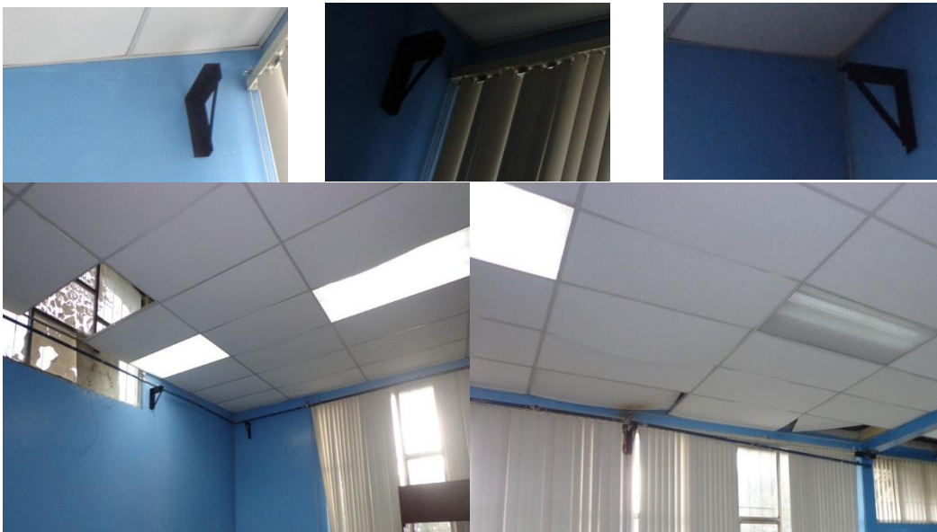
Figura LXVI. Montaje de la tubería sobre los soportes.
