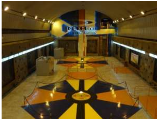
FIGURA IV.50. Central Hidroeléctrica Agoyán Fuente: CELEC EP - Hidroagoyán
