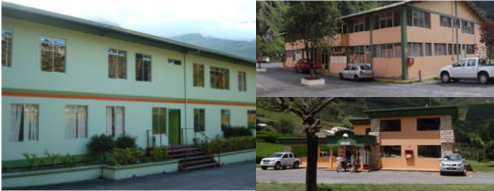
FIGURA IV.48. Oficinas Administrativas Fuente: CELEC EP - Hidroagoyán
