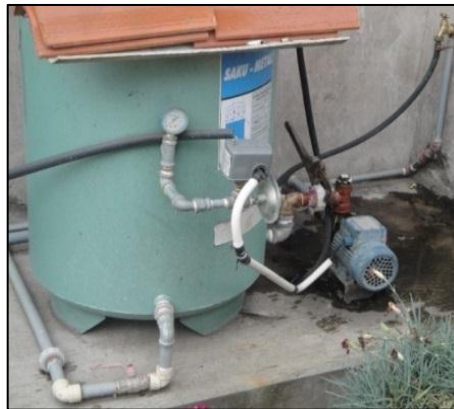
Figura 50. Desconexión de tubería
