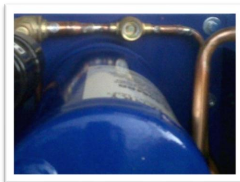
Figura 79. Visor líquido y filtro secador.
