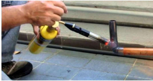
Figura 95. Soldadura de plata al 5% como material de aporte.
