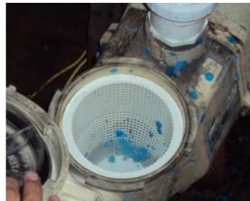
Figura 6. Prefiltro del sistema actual
