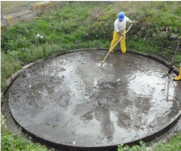
c.) Filtro anaerobio saturado de lodo.
