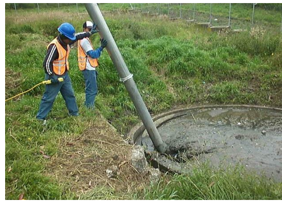
b.) Intervención del personal de la EP. EMAPA-A en mantenimiento de infraestructura y limpieza del exceso de lodo del filtro FAFA con la ayuda del camión vacuum.
