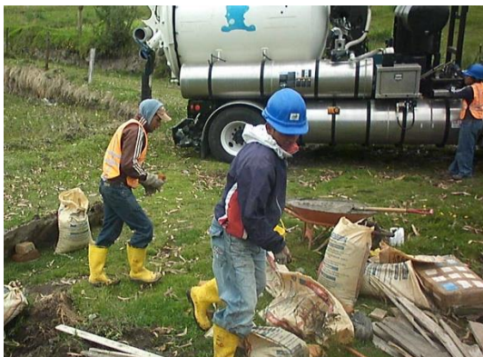
b.) Intervención del personal de la EP. EMAPA-A en mantenimiento de infraestructura y limpieza del exceso de lodo del filtro FAFA con la ayuda del camión vacuum.
