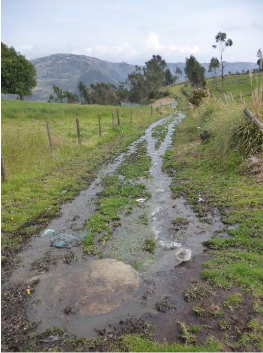
a.) Tubería de alcantarillado sanitario colapsada
