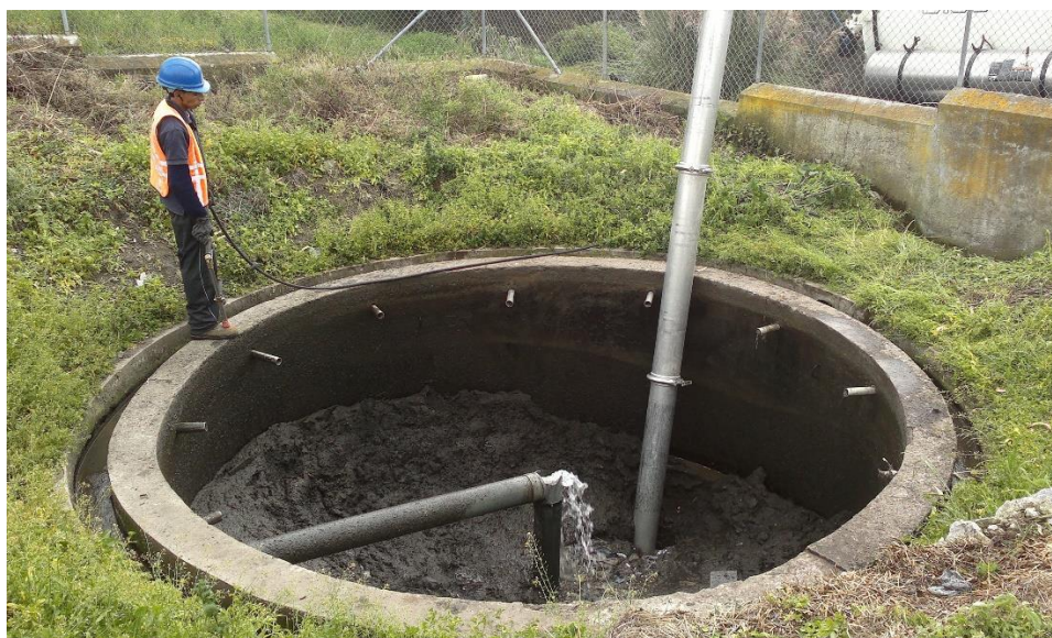
d.) Limpieza parcial de lodo acumulado.
