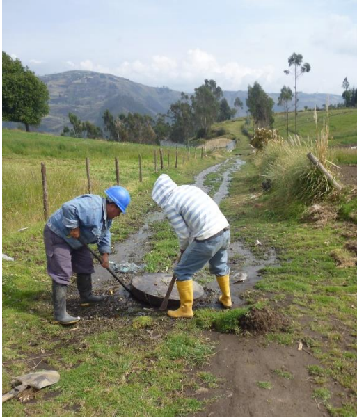
a.) Limpieza de pozos y tubería de alcantarillado sanitario que conduce el agua hacia la planta.
