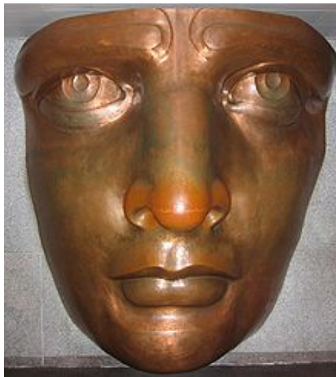
Figura 7. Cara de la Estatua de la Libertad de Nueva York, hecha con láminas de cobre sobre una estructura de acero
