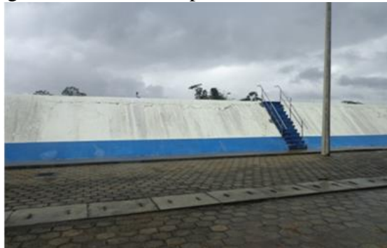
Figura. 21: Piscina de pre sedimentadores.
