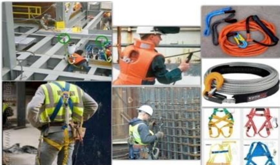
Figura.55: Elementos de detención de caídas.
