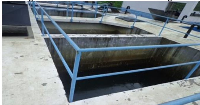
Figura. 35: Cubilotes de filtración de agua.
