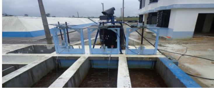
Figura. 34: Unidad de mezclado rápido.
