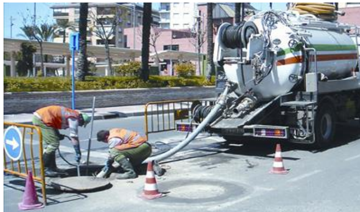
Figura. 47: Línea de revisión de alcantarillado de Shushufindi.
