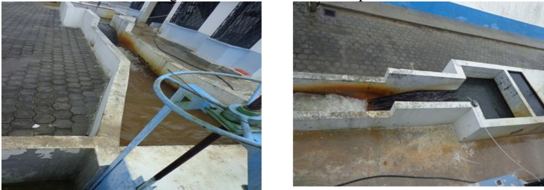
Figura. 22: Unidad de mezcla rápida.
