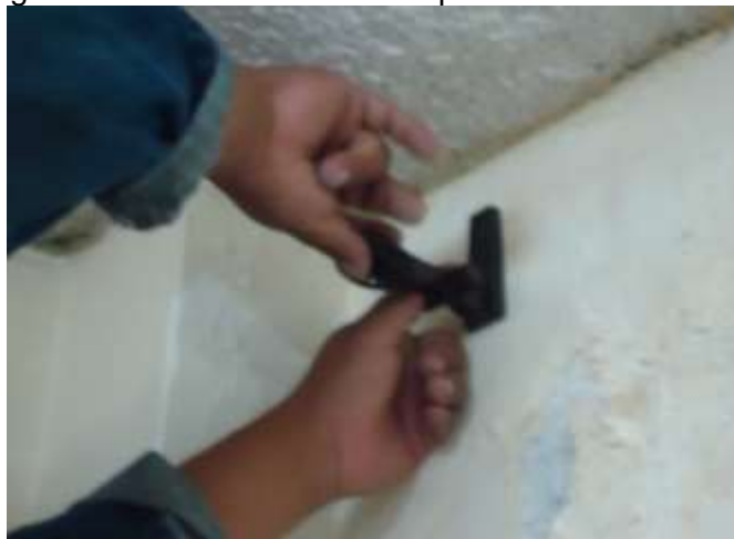
Figura 20. Colocación de los soportes de las cámaras.
