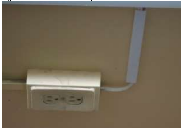
Figura 24. Conexión en paralelo al tomacorriente.
