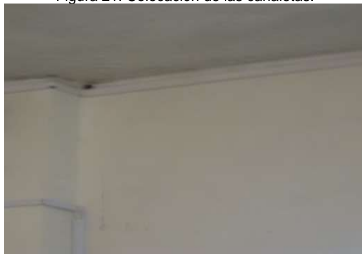
Figura 21. Colocación de las canaletas.
