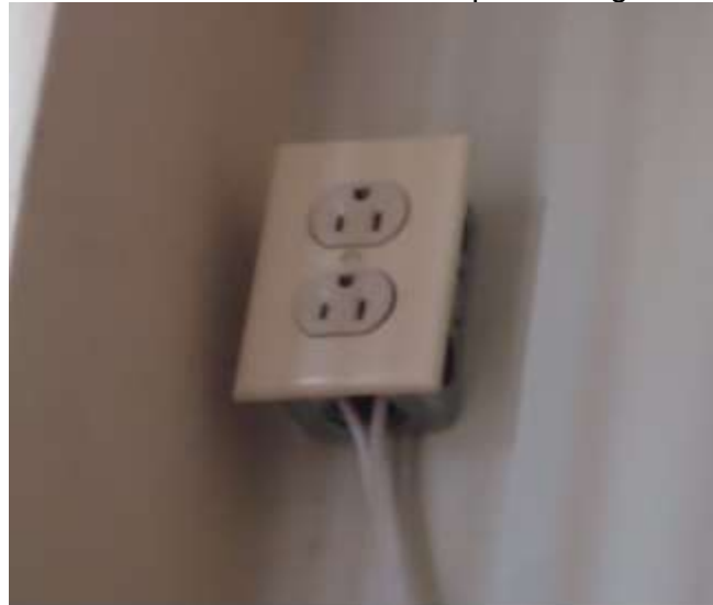
Figura 23. Colocación del tomacorriente para energizar la cámara.
