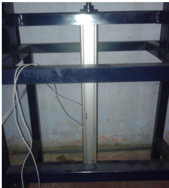
Figura 106. Colocación de los sensores magnéticos
