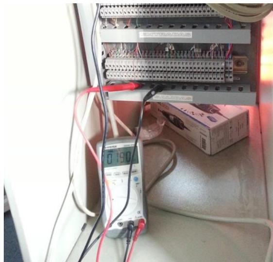
FIGURA. V.4 COMPROBANDO BORNERAS<sup>109</sup>
