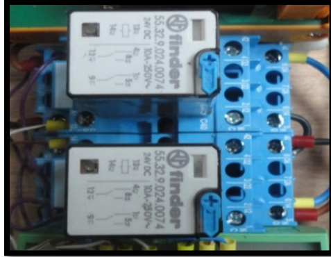
Figura V-15 Relés de Potencia (EJE X) 91
