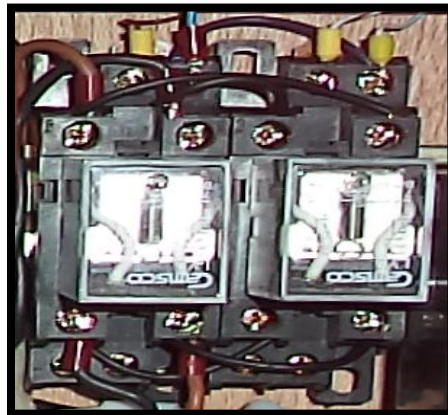
Figura V-16 Relés de Potencia (EJE Y) 92
