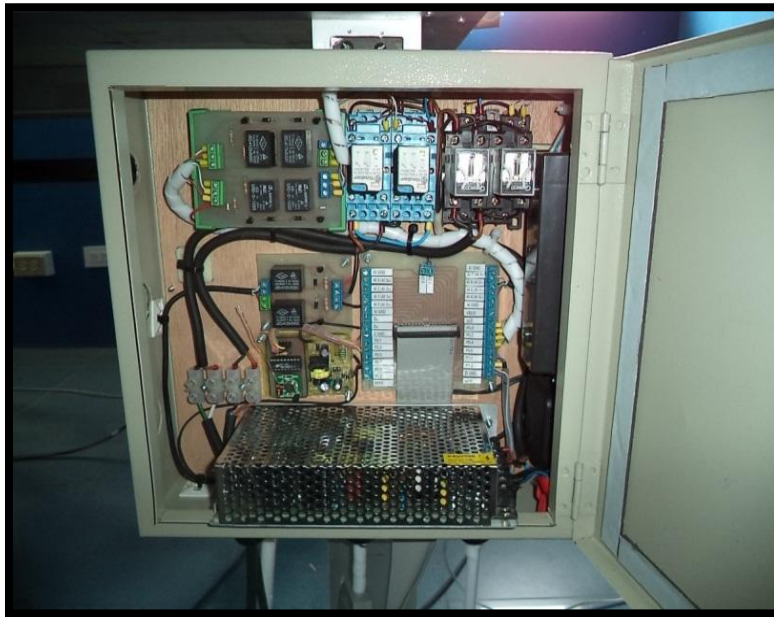
Figura V-1 Tablero de Control de la Maqueta 77
