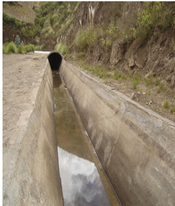
FOTO 6: Canal Principal Guargualla-Licto.
