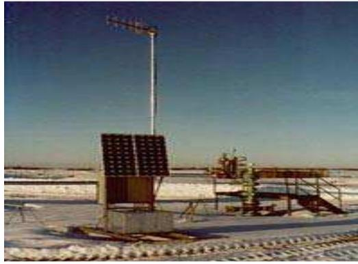
**Figura N III.21.** Ejemplo de una RTU con panel solar utilizado en plantas Petroleras
