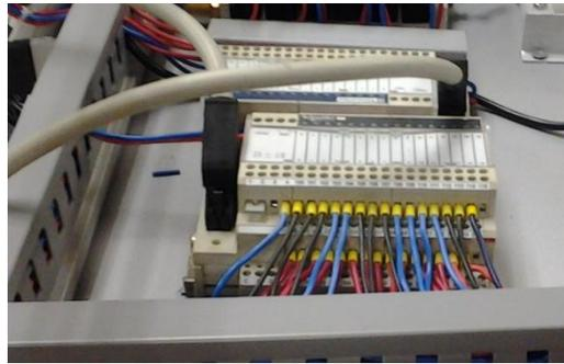
**Fig. III 46.** Cableado Módulos de Entradas y salidas
