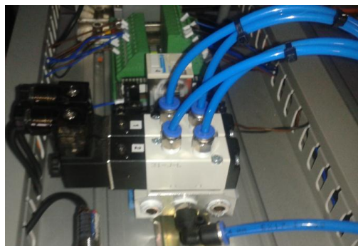
Figura IV.62 Electroválvulas 5/2 68
