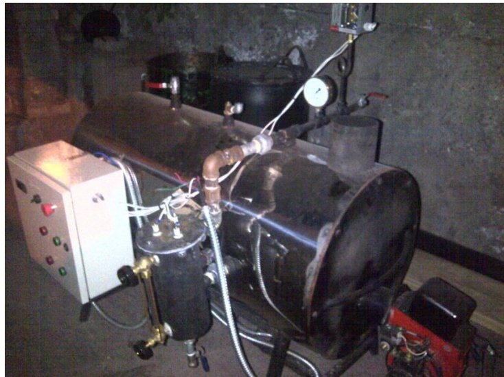
Figura V. 27. Caldera Piro Tubular Horizontal
