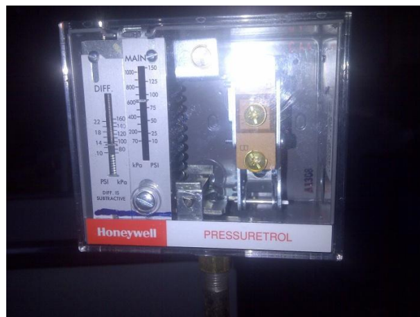
Figura III.21. Presóstato de operación
