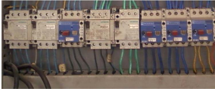
**FIG. IV. 36. Guardamotores de las bandas bajo silos**
