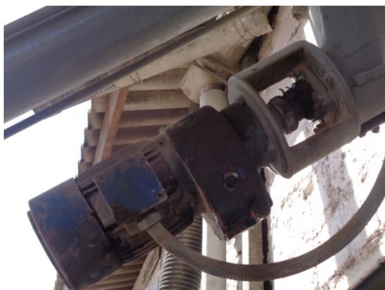
**FIG. IV. 28. Motor utilizado para transportar cemento**
