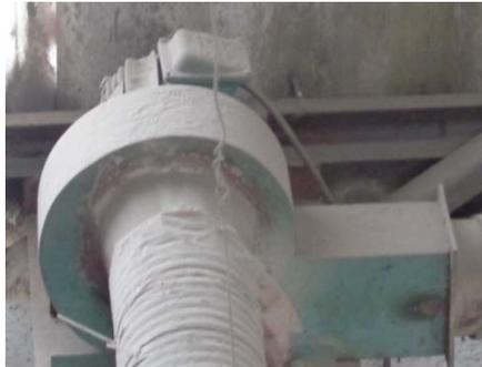
**FIG. IV. 26. Motor del sistema extracción de partículas**
