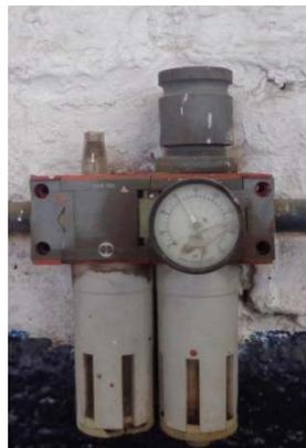
FIG. IV. 39. Unidad de mantenimiento instalada en la salida del compresor
