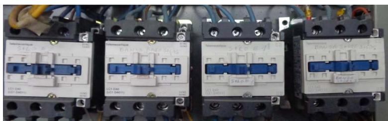
**FIG. IV. 35. Contactores para activar las bandas bajo silos**
