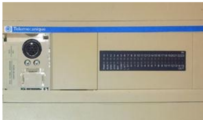
Figura IV-70. Montaje del PLC Telemecanique TWDLCAE40DRF 112
