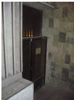
Foto IV :1A Parquadero Fuente: GADPCH
