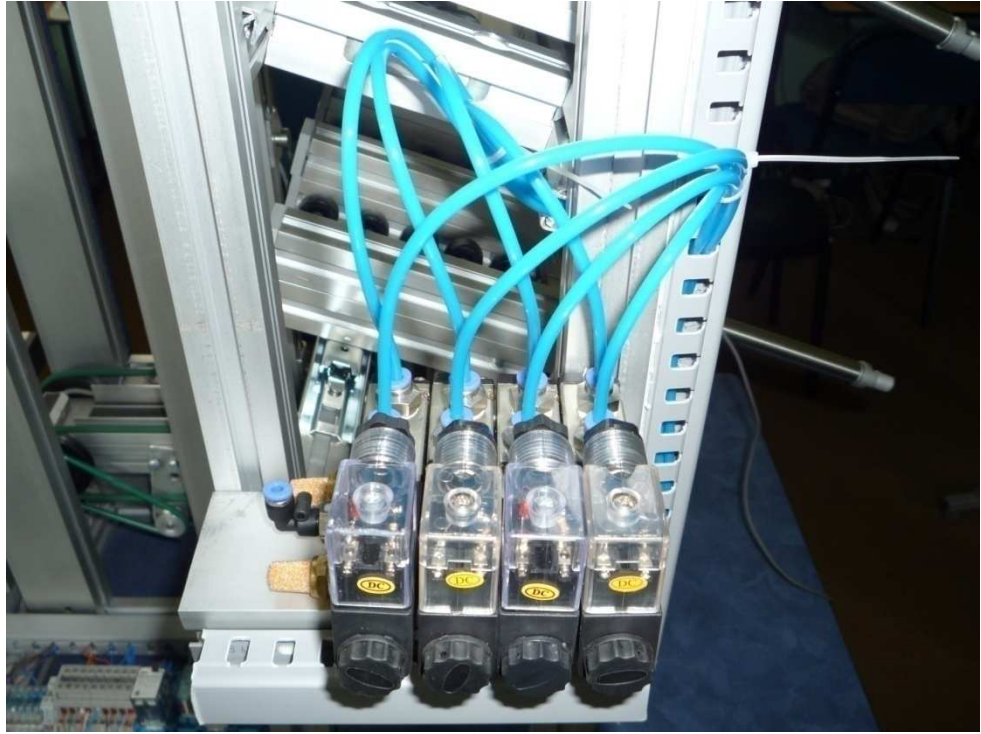
Figura IV.62. Manguereado de válvulas.
