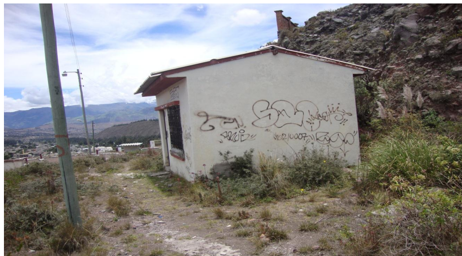
Fotografía N°4. Situación actual de la planta de tratamiento de agua potable de Lluishi
