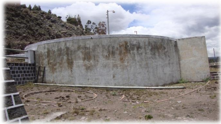
Fotografía N°1. Tanque de Distribución de Lluishi
