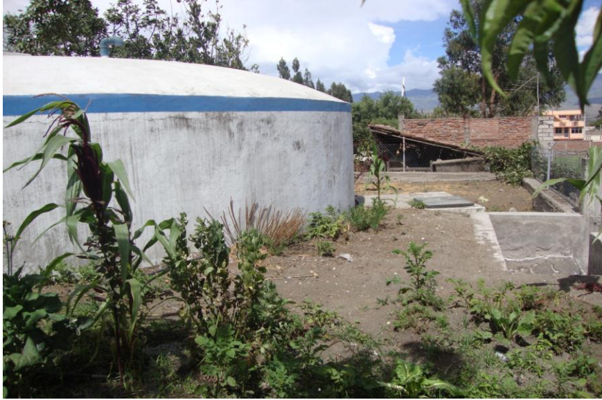
Fotografía N°7. Interior del área del tanque de distribución de la Inmaculada
