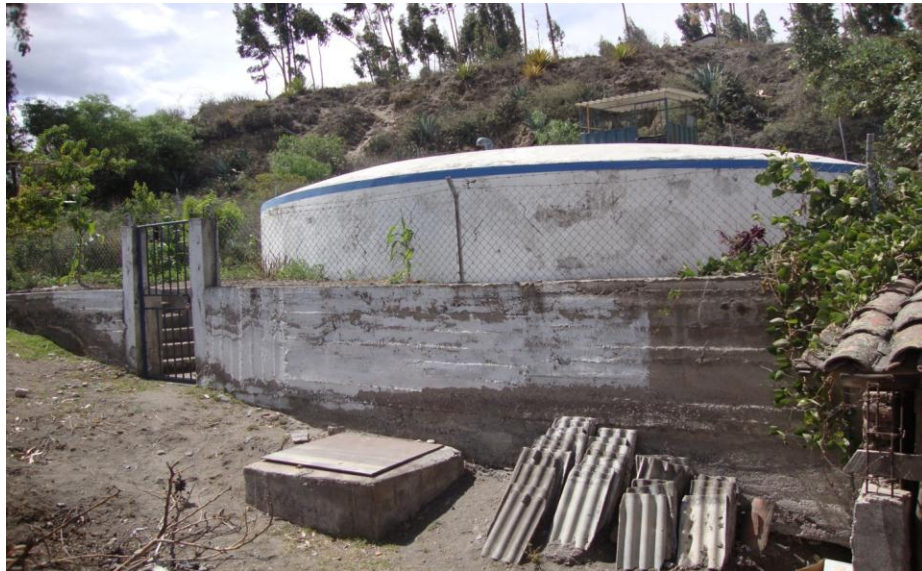
Fotografía N°6. Exteriores del área del tanque de distribución de la Inmaculada
