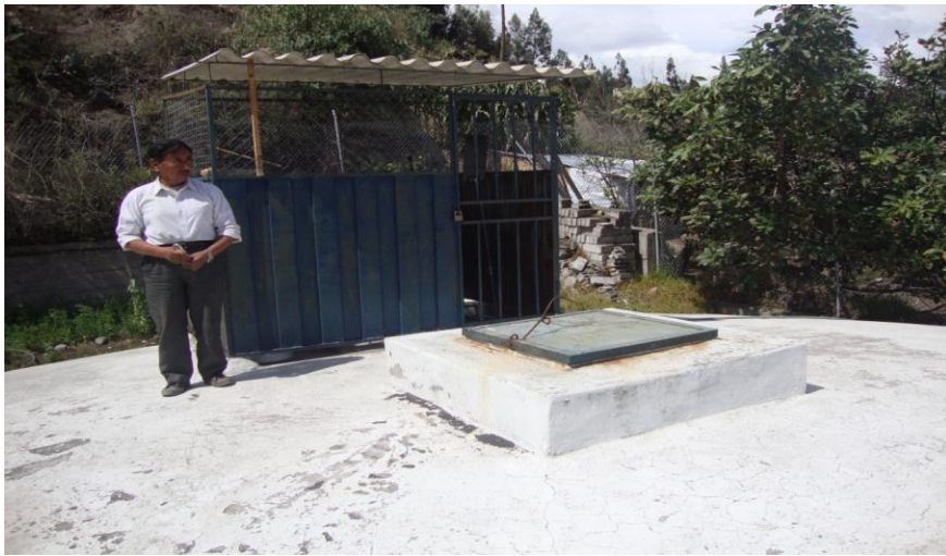
Fotografía N°8. Área de cloración del tanque de distribución de la Inmaculada
