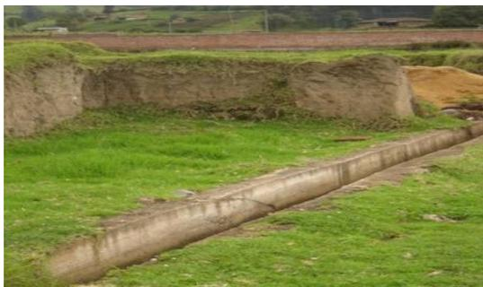
Figura 22. Canal Revestido
