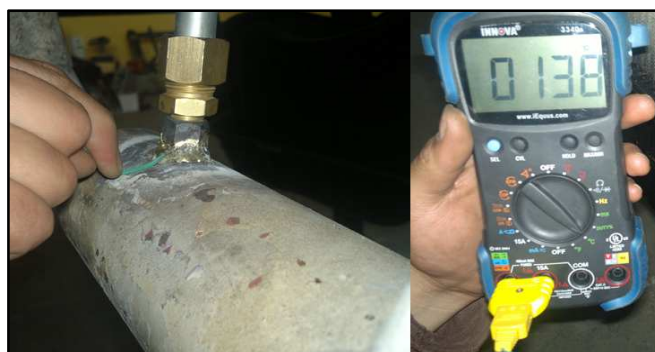
Figura 46. Medición de temperatura en el ducto de escape
