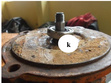
Figura 49. Sello mecánico averiado
