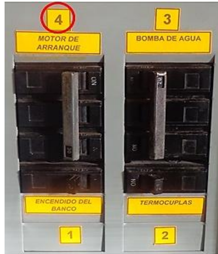
Figura 91. Accionamiento del motor de arranque
