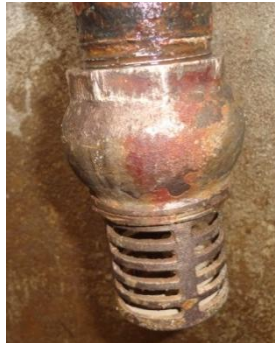
Figura 18. Válvula de pie
