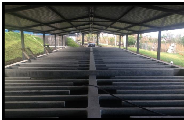
Figura 2.2 Floculadores de serpentin
