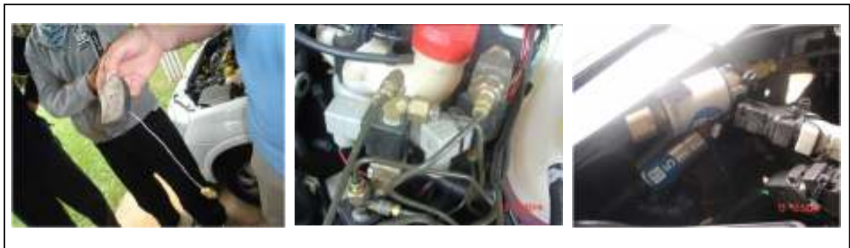
Figura 34 Instalación de Termocuplas y Transductores de Presión
