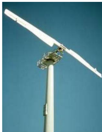
Figura 12. Aerogenerador de dos palas
