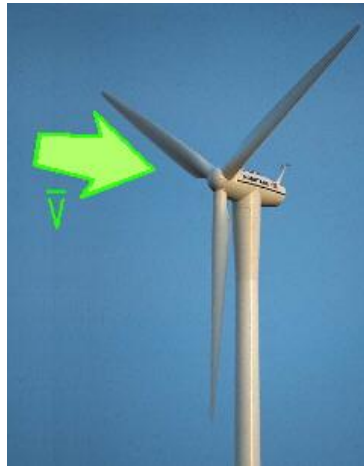
Figura 9. Aerogenerador eje horizontal a barlovento
