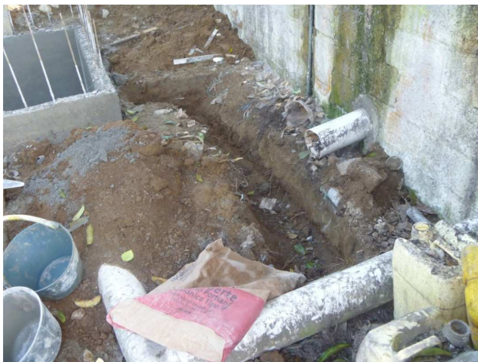
Fotografía 6. Construcción de los tanques de sedimentación.
