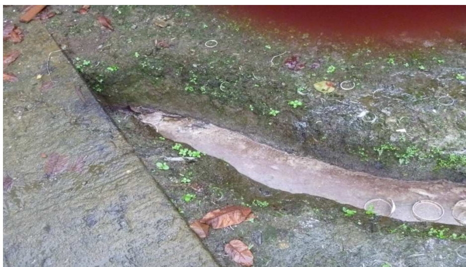
Fotografía 3. Cauce de los residuos industriales líquidos (RILES), al río Baba.
