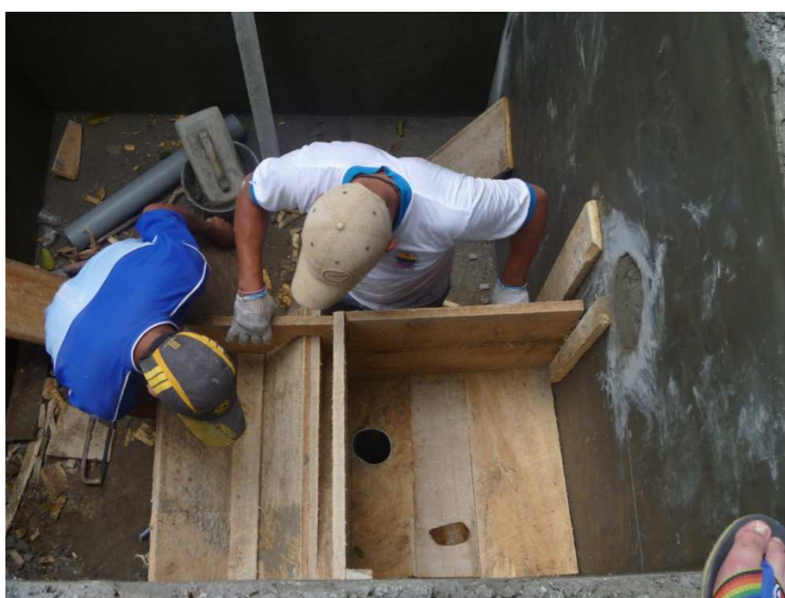
Fotografía 7. Construcción de las canastas de filtración.
