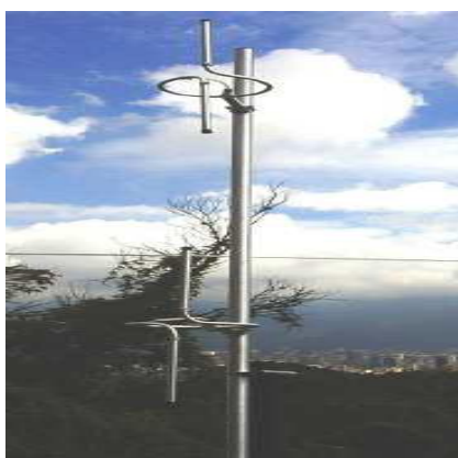
FIGURA V. 42. ANTENA TIPO RADIADOR.
