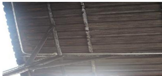
Fig. V. 7. Tubería dirigida a los detectores
