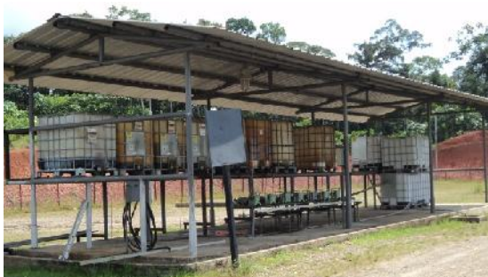
Fig. III. 13. Inyección de Químicos
