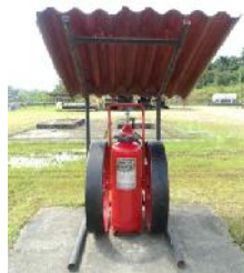
Fig. III. 27. Extintor móvil con ruedas
