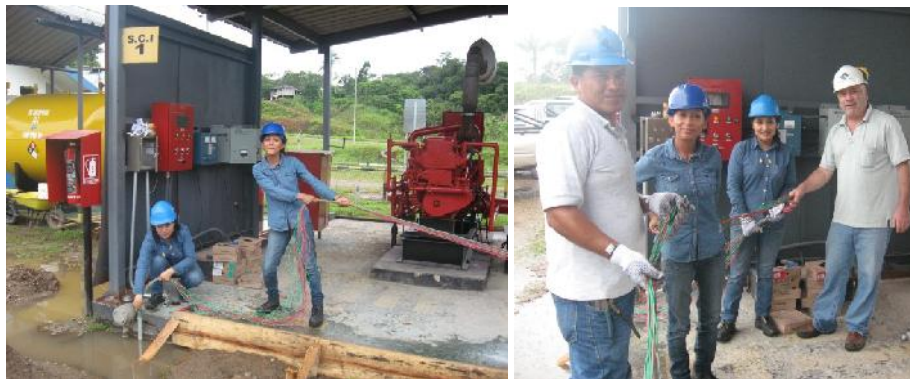
Fig. V. 10. Tendido de cables Fuente: Estación Sansahuari
