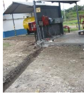
Fig. V. 3. Zanja terminada Fuente: Estación Sansahuari
