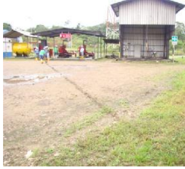
Fig. V. 2. Zanja para la tubería Fuente: Estación Sansahuari
