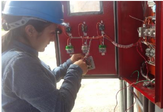
Fig. V. 27 Modificación tablero SCI.
