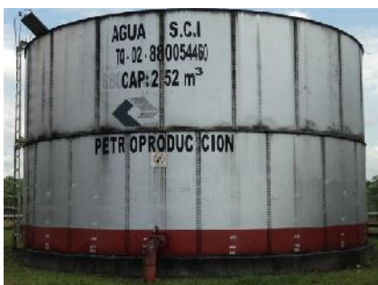
Figura. III. 19. Tanque de agua SCI Fuente: Estación Sansahuari
