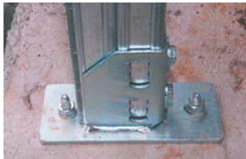
Figura V-4 Base de carril para fijar los carriles al suelo
