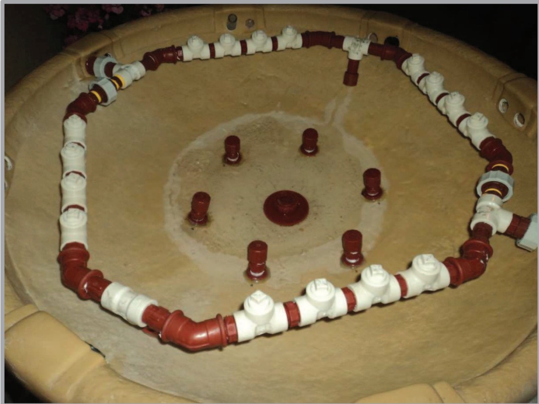
Figura III.56: Conexión de toberas AB exteriores
