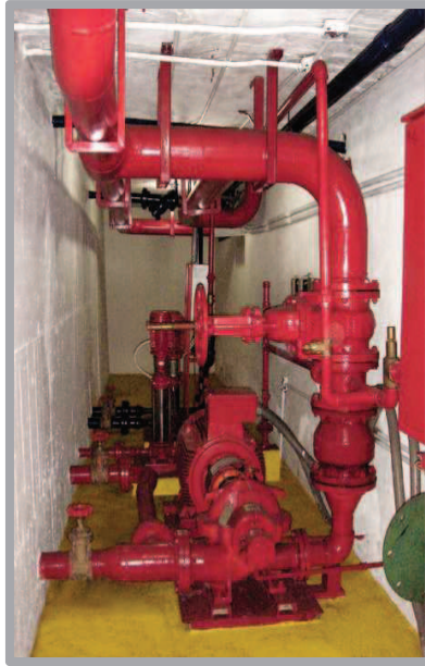
Figura II.7: Cuarto de Bombas
