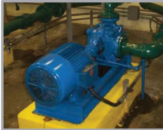
Figura II.5: Bomba de pozo seco
