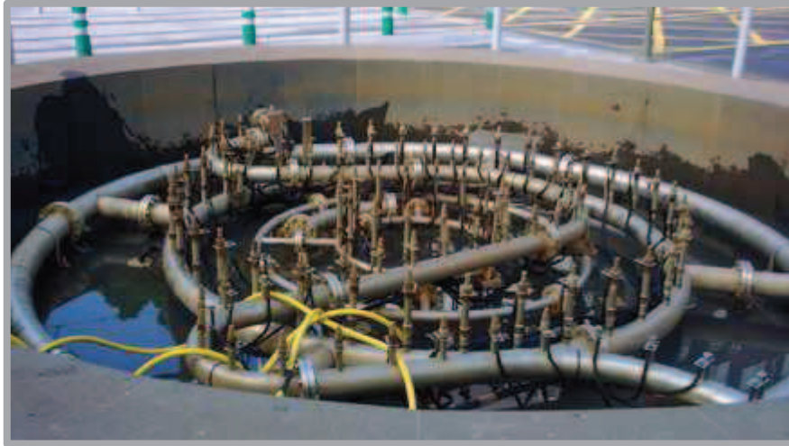
Figura II.8: Sistema de impulsión de una fuente
