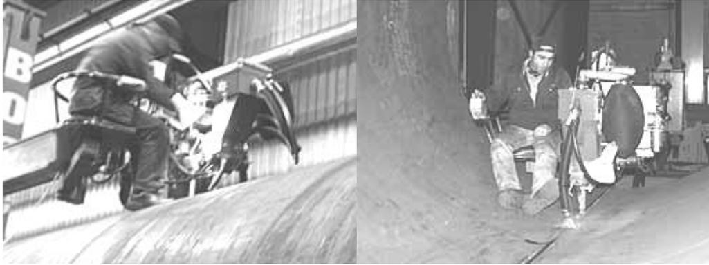
**Figura III.11 Soldadura externa e interna de la sección de una torre**
