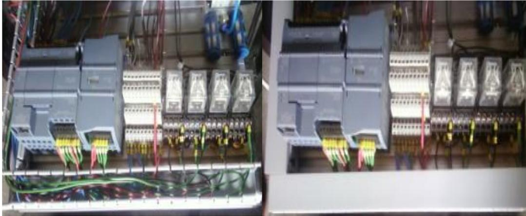
**Figura V- 6: Tablero de aluminio para el control del proceso**
