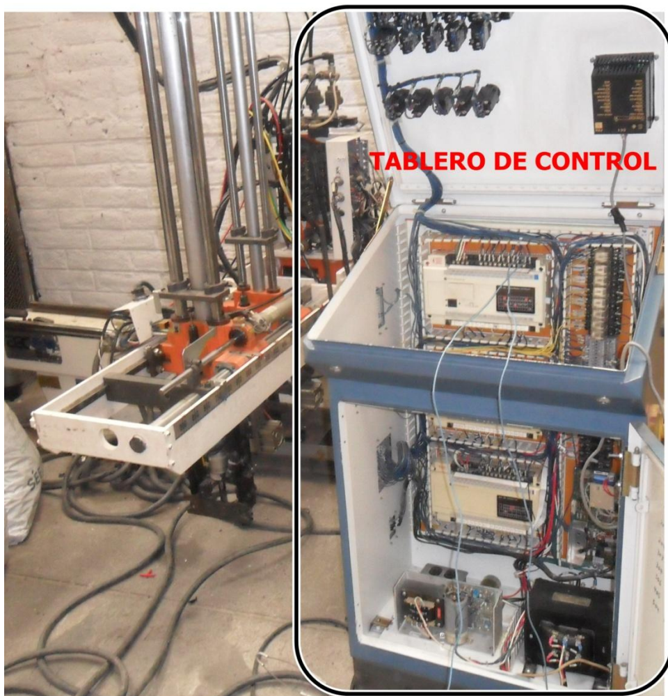
Figura III.41. Tablero de Control estado anterior del robot
