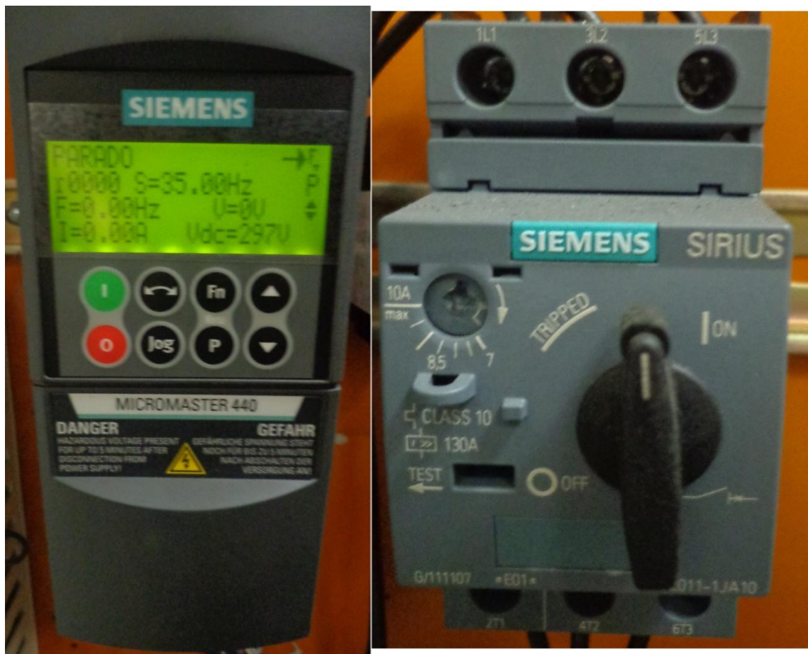
Figura III.59. Variador y guardamotor para el motor PSC
