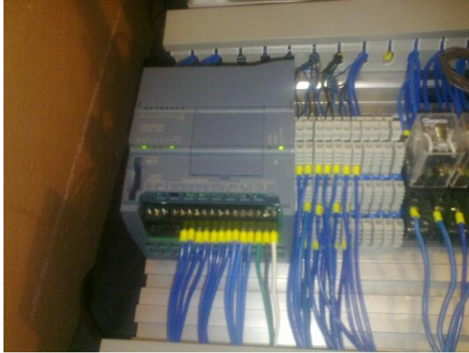
Figura. IV-23. Conexión de Entradas y Salidas al PLC
