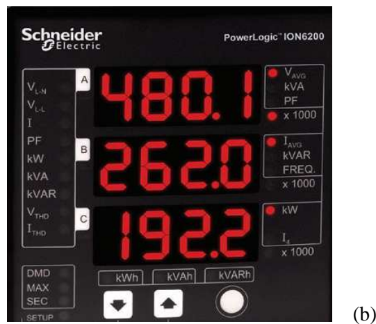
Figura 3.3: (a) Modulares de Control y Monitoreo. Dentro de la caseta la subestación se encuentran estas caja en donde se encuentra el todo el sistema de control electrónico para el sistema de abastecimiento eléctrico de la planta.
