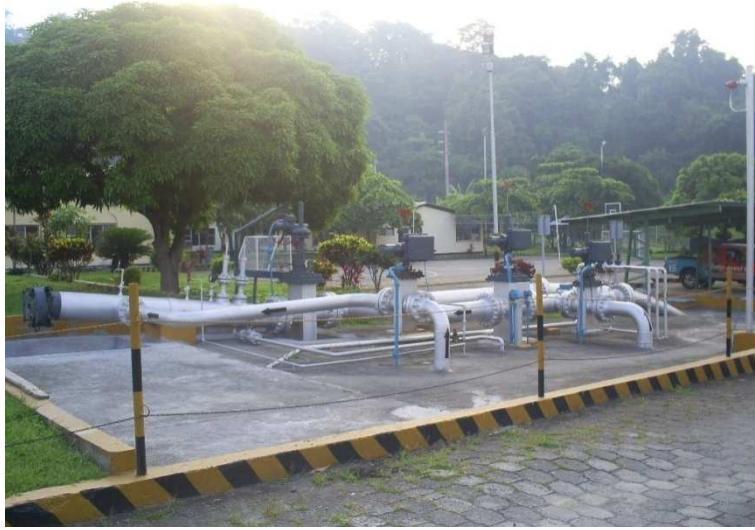
Figura 3.17: Trampa de Rascadores.
